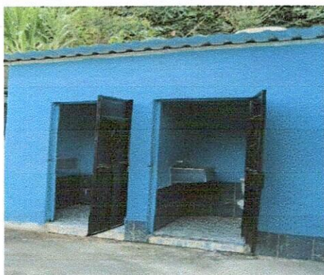
Foto 3: Mejoramiento de puertas de baños, cambio de estructura de techo y cubierta de lamina calibre 26. Ampliacion de pared de baño.
