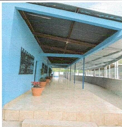
Foto1: Cambio de piso de torta de cemento a piso ceramico aula1,2,3 y corredor.
